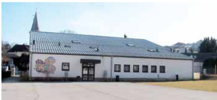
Die Mehrzweckhalle wird mit einer Photovoltaikanlage ausgestattet
