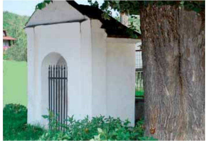
Anger-Kapelle vor dem Abriss
