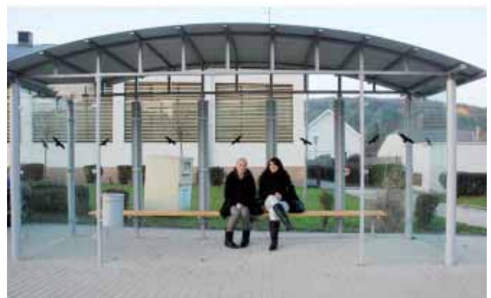
Neues Buswartehaus wird errichtet
