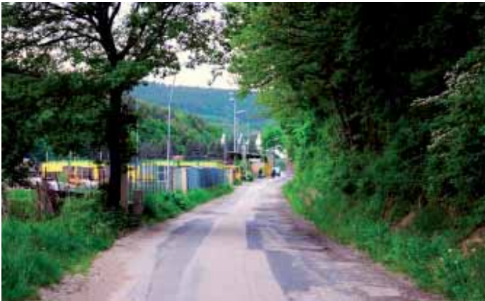
In der Schöllingstraße wird für Hochwasserschutz investiert
