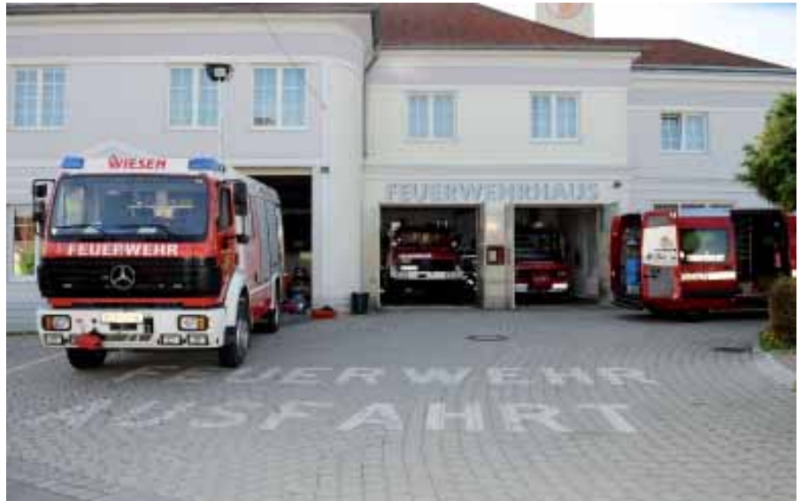
Altes Feuerwehrhaus entspricht nicht mehr den heutigen Anforderungen
