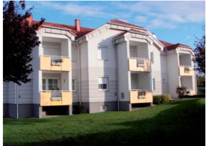
Im Ried Hohenäcker entstehen weitere Wohnungen
