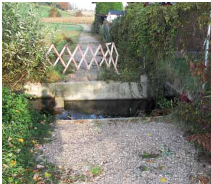
Für den Radfahrweg über den Bach beim Römersee wird eine neue Brücke errichtet
